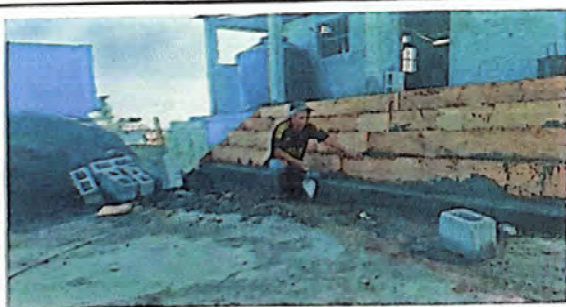
Foto 5: Evidencias de la construcción del muro y las gradas de la cocina escolar de la escuela.
