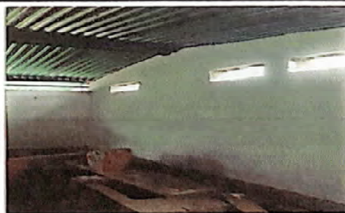
Foto 6: Avances del proceso del repello y cernido de la cocina escolar del establecimiento.
