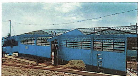
Foto 1: Foto que evidencia el proceso del desmontaje del techo del edificio escolar de la escuela.
