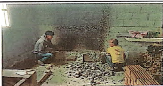
Foto 3: Foto que evidencia el proceso de la construcción de las estufas mejoradas de la escuela.
