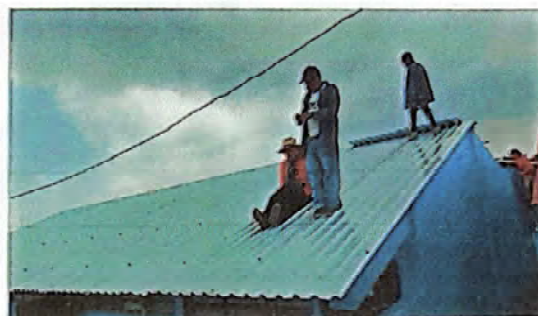
Foto 2: Proceso de la instalación del techado del Edificio Escolar de la escuela oficial Rural Mixta Aldea Piedra de Fuego.
